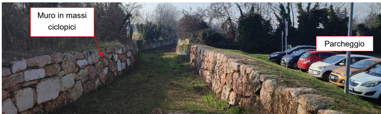
Figura 14: Argini tra la sezione 9 e la 24 in corrispondenza del parcheggio
