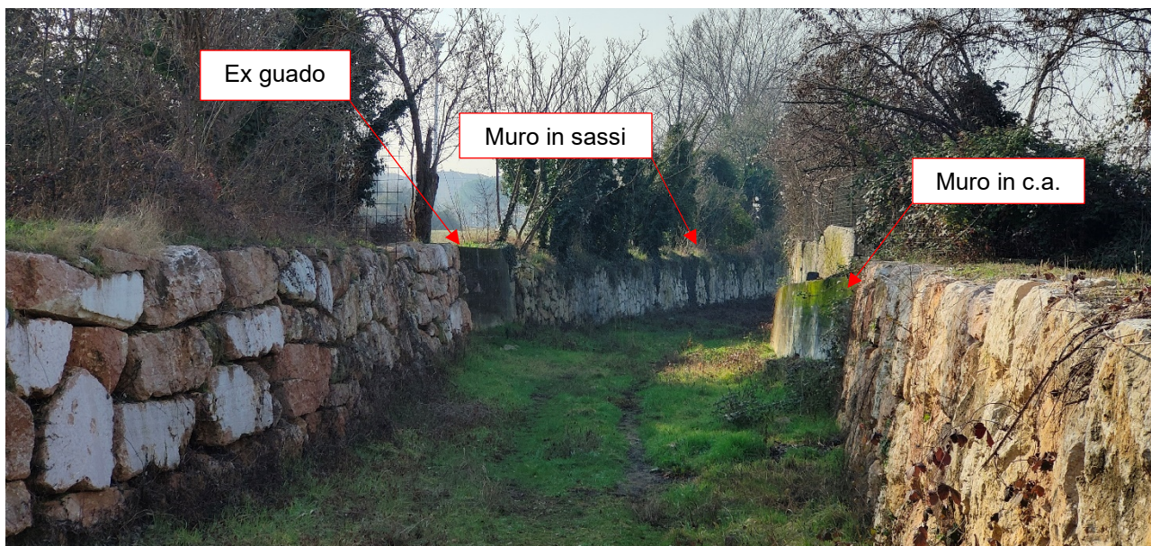
Figura 15: Argini tra la sezione 24 e la 37
